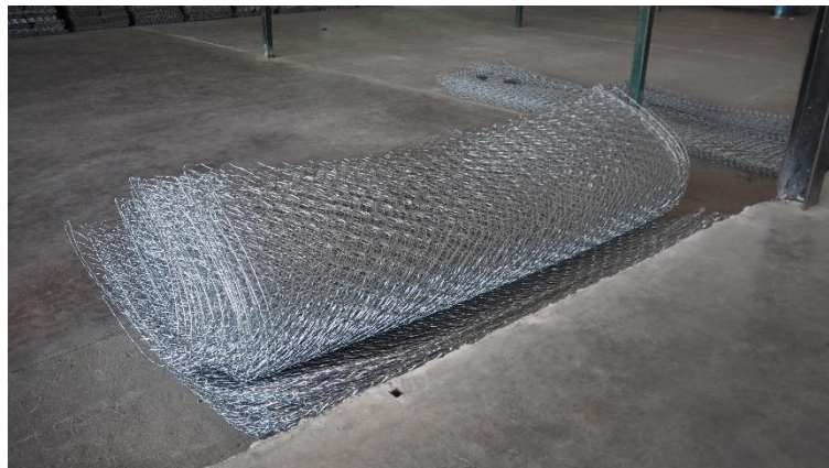
ภาพ 4.10 ลวดถักที่วางรอทำการประกอบ
